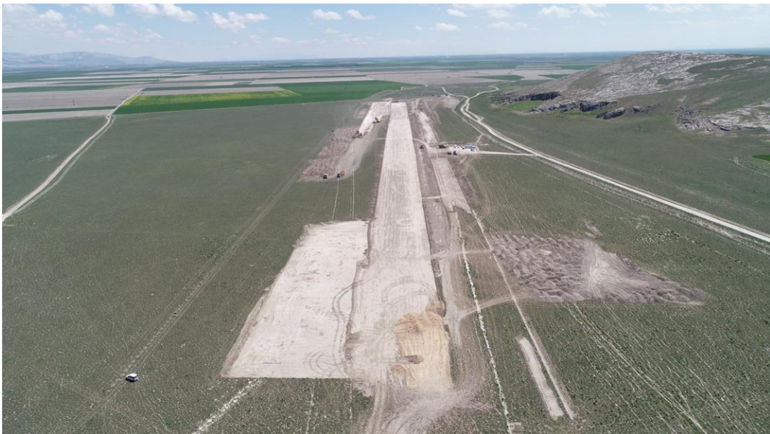
Pilotaj Bölümü Eğitim Merkezi İnşaatı
